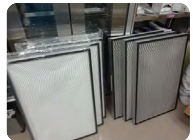
消耗品交換(HEPAフィルタ)
